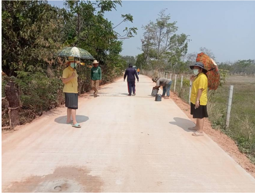
ภาพก่อสร้างถนนคอนกรีตเสริมเหล็กภายในตำบลภูแล่นช้าง
